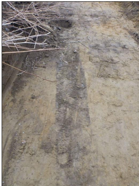
Vasen kuva: Arkeologien valvonnassa kaivettu kaivanto 2. Kaivannon oikeassa reunassa näkyy tumma raita, tässä kohti on kaapelilinja. Kuvattu lounaaseen. Oikea kuva: Kaapelikaivannon aiheuttama tumma läikkä kaivannon pohjalla. Kuvattu pohjoiseen.
