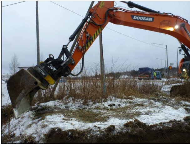
Kaivannon 2 kaivua aloitetaan itäpästä. Kuvattu lounaaseen.
