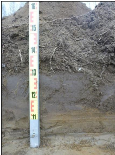
Vasemmassa kuvassa pohjoisprofiili kaivannon länsipäässä ja oikealla pohjoisprofiili kaivannon itäpäässä.
