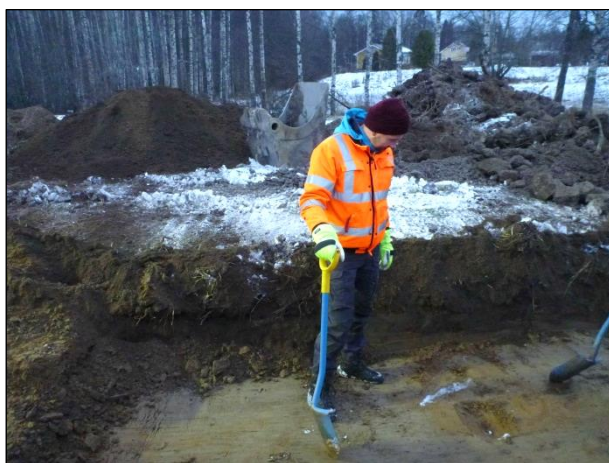
Teemu Tiainen tarkastelee kaivetun kaivannon 1 pohjaa, kaivannon itäpäässä.
